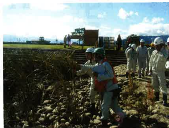
写真1 耐震補強工事現場における葎の生育の確認状況～エコミーティング活動より
