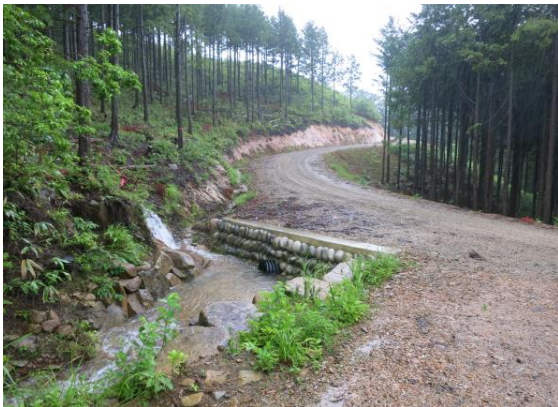
1) 排水コントロールの状況
