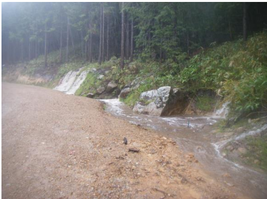
3) 路面浸食なし、素掘り側溝でマネジメント
