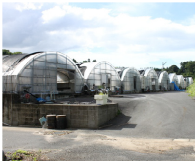
コンクリート池の外観
