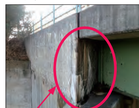
劣化・損傷しやすい桁端部
